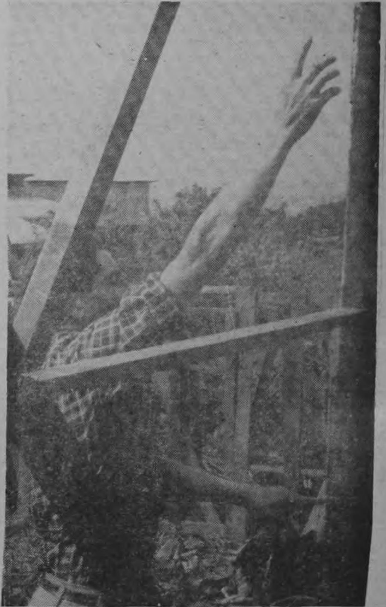
"...De aquí a allí hubo que soldar ayer por la mañana, porque la explosión había dañado esta parte de la torre"; comentó un guarda de la Sub-Estación.
