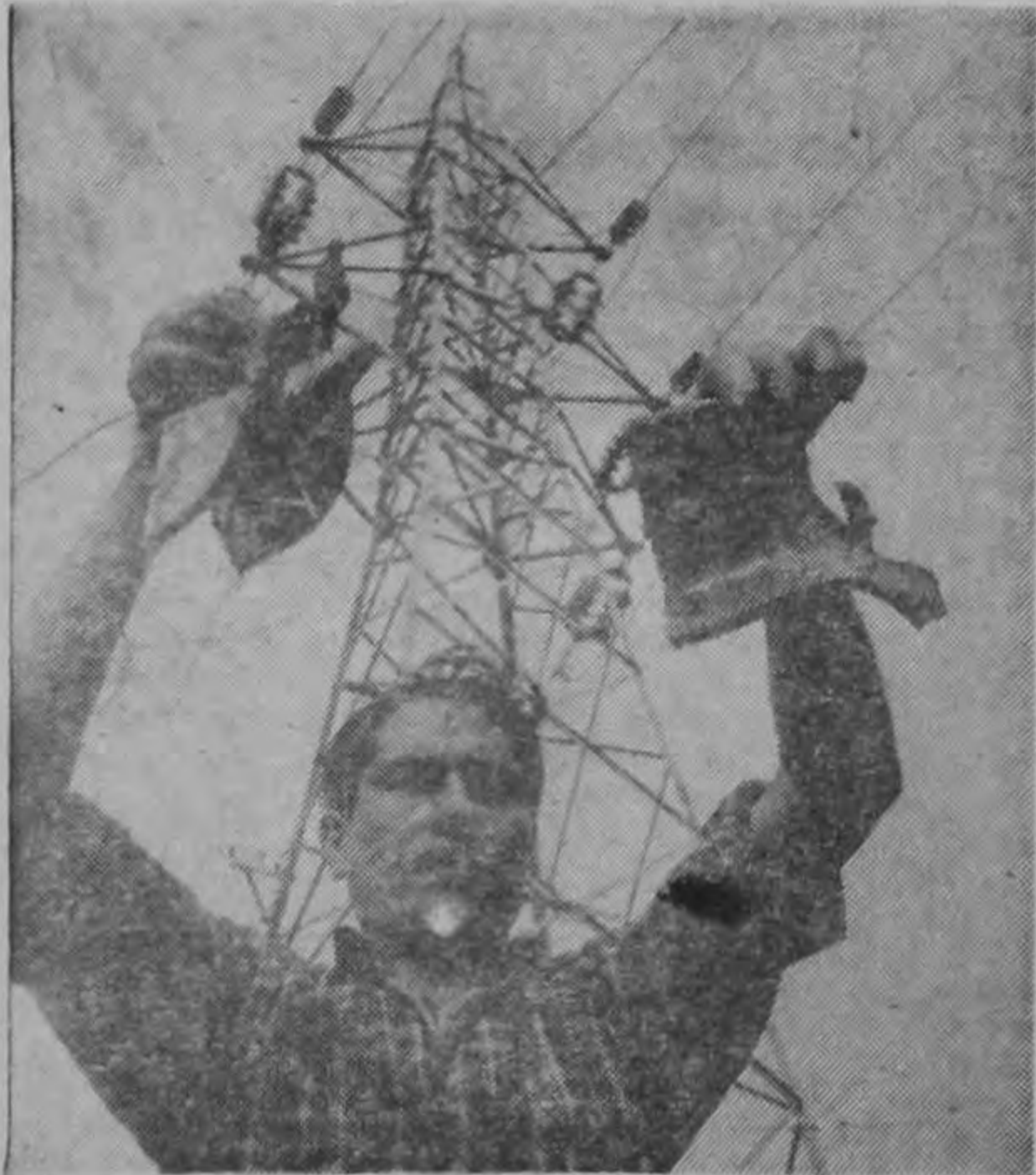
En guarda muestra partes de la torre, que fueron voladas por dinamita, en la Sub Estación de Fuerza y Luz de La Uruca. Atrás la torre que se trató de dinamitar (Fotos de H. Araya)
