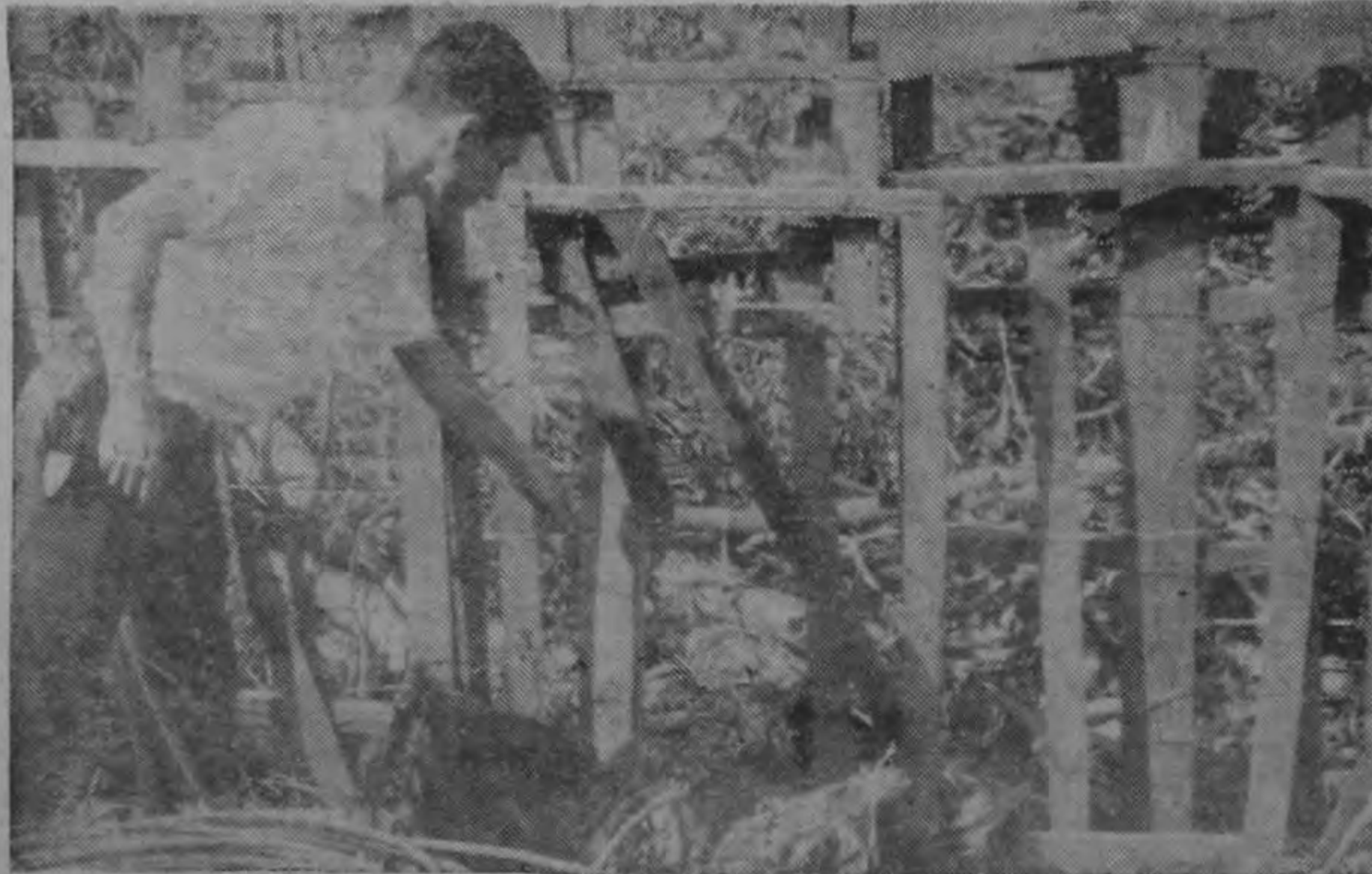
A través de este espacio hecho en una baranda traía era del edificio de la subestación de La Uruca, penetraron para colocar el explosivo, y luego
